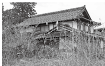
管理不全の空き家
