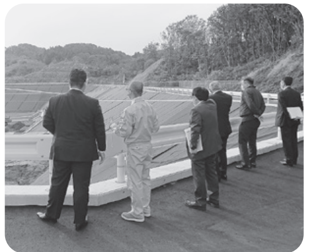
一般廃棄物最終処分場
