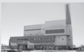
鶴岡市新ごみ焼却施設
