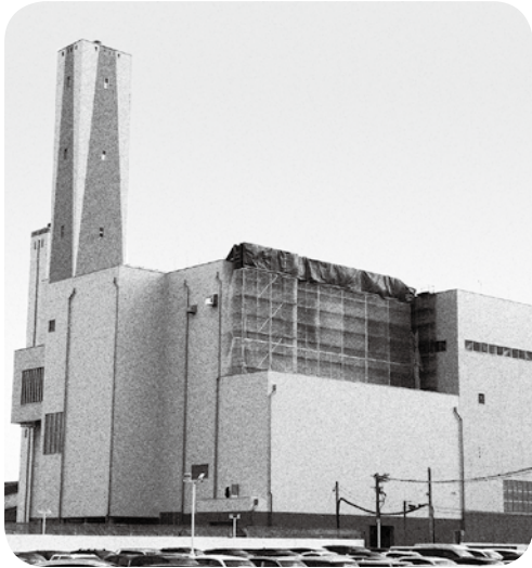
建設中の新ごみ焼却施設
